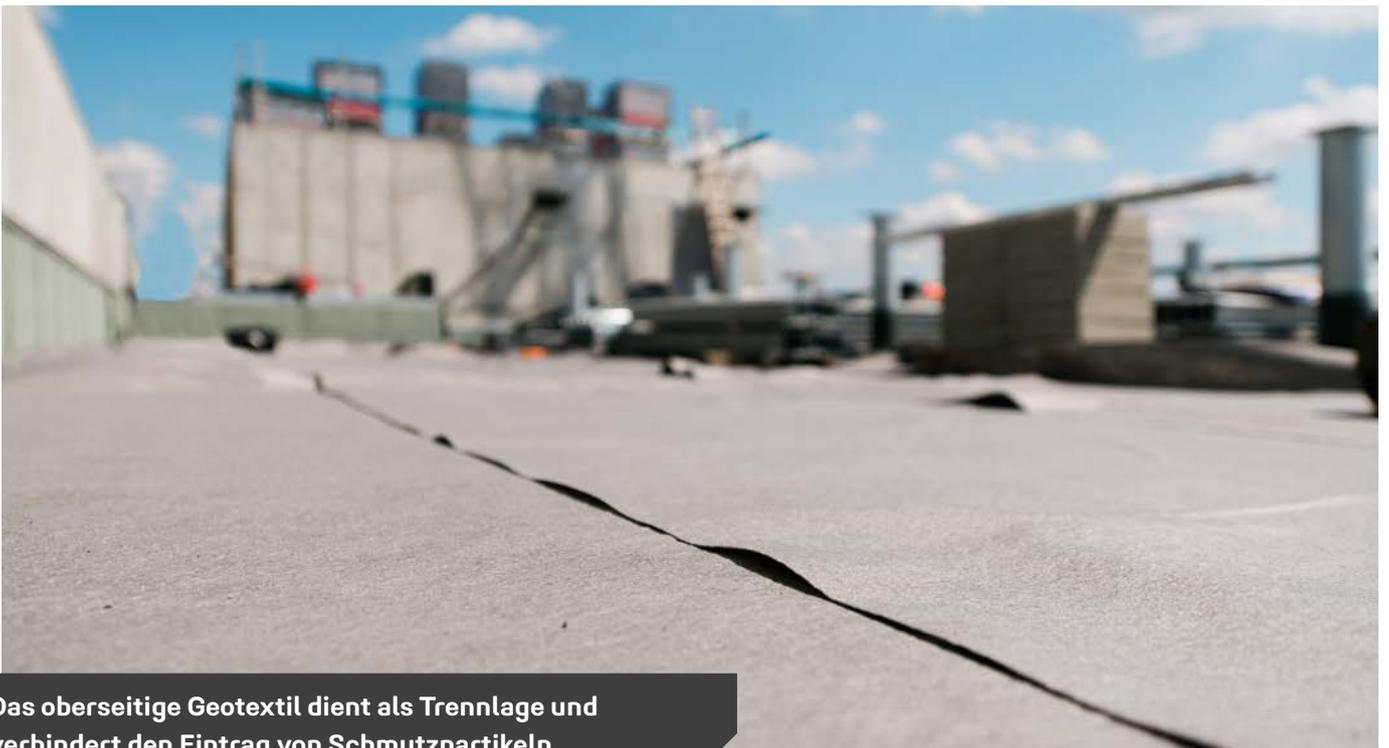
Das oberseitige Geotextil dient als Trennlage und verhindert den Eintrag von Schmutzpartikeln.
