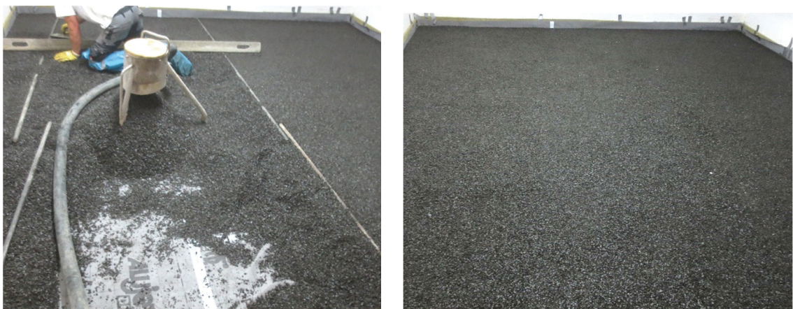
Abbildung A 2.2: Montagesituation – Einbau der Ausgleichs- und Schalldämmschüttung
