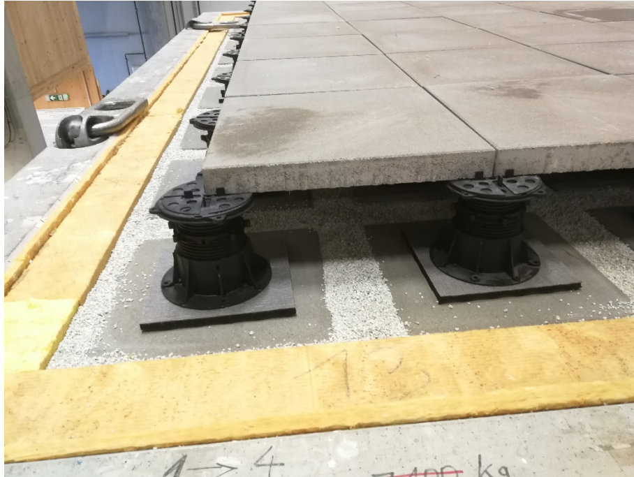
Abb. 3: Der begehbare Flachdachaufbau wurde mittels Trittschalldämmung (TDPT 20, Saint-Gobain Rigips Austria GmbH) umlaufend zu Prüfraumen hin entkoppelt.
