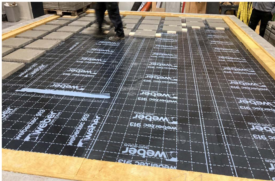
Abb. 2: Auflegen der Betonplatten (400 × 400) mm 2 auf die Kaltselfstklebebahn.
