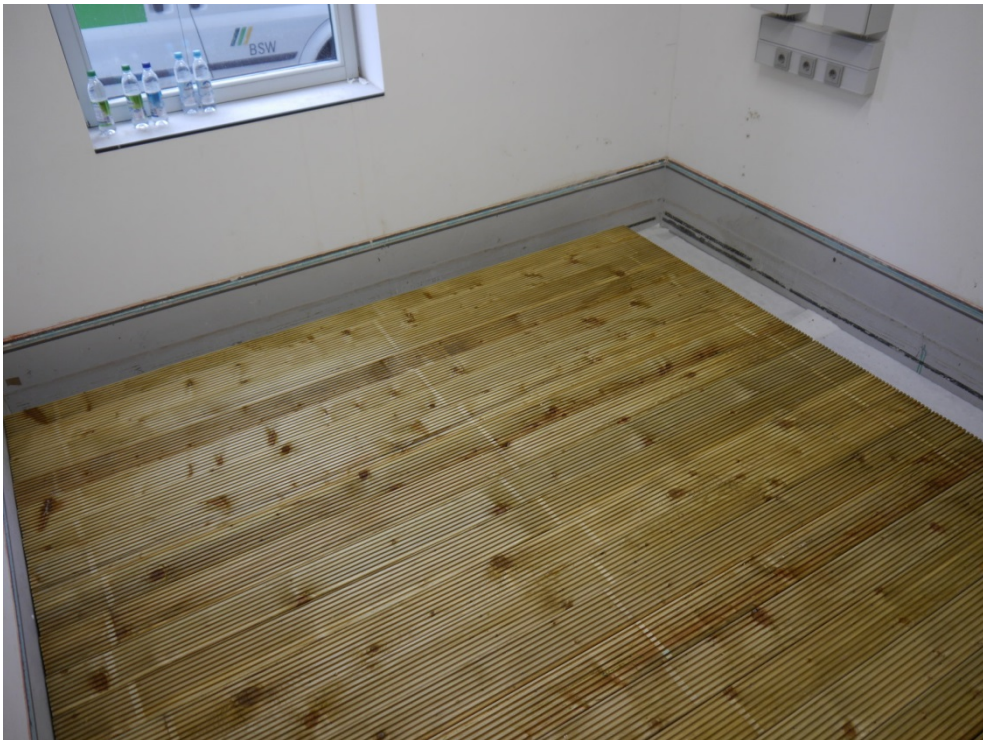
Abbildung B.6. Prüfaufbau im Deckenprüfstand: prüffertig.
