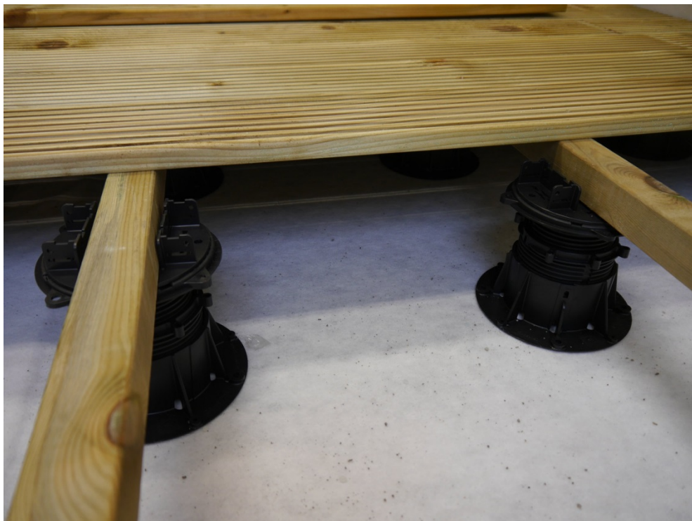
Abbildung B.4. Prüfaufbau während der Montage: Stelzlager mit Traglattung und teilweise verlegten Holzdielen.
