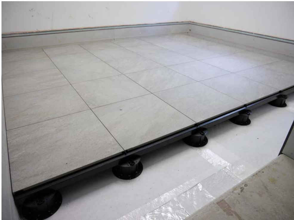
Abbildung B.5. Prüfaufbau im Deckenprüfstand: prüffertig.
