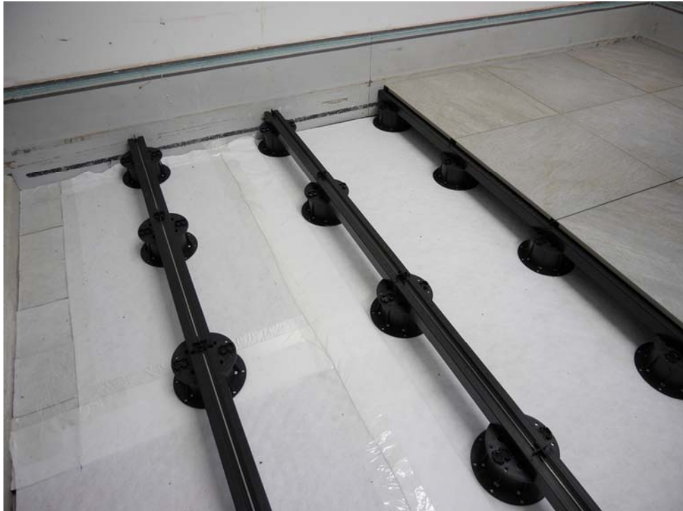
Abbildung B.3. Prüfaufbau während der Montage: Tragprofile auf Stelzlagern und Trittschalldämmbahn.
