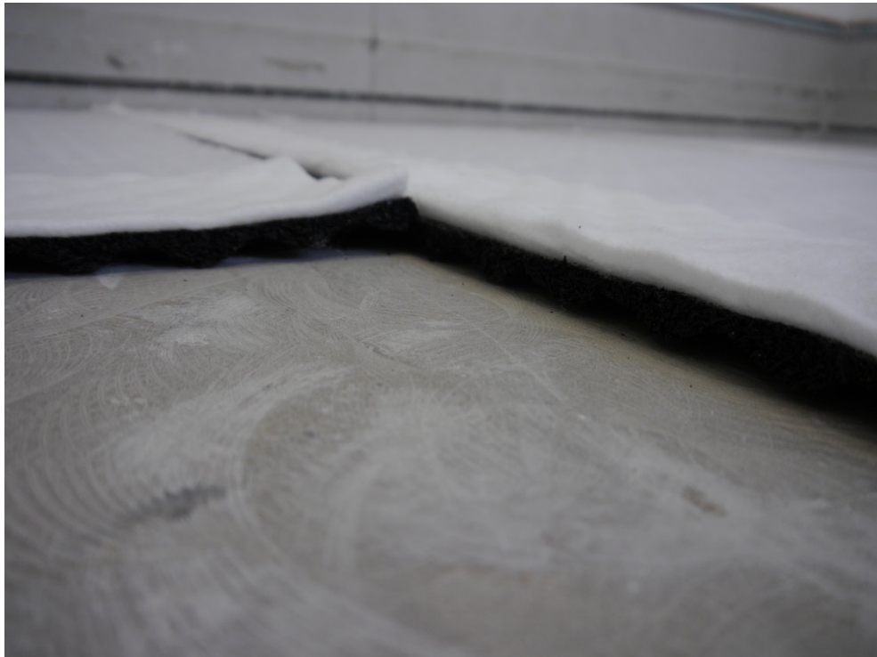
Abbildung B.1. Auslegen der Trittschalldämmbahnen Regupol® sound and drain 22 auf der Betonrohdecke.
