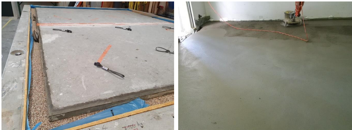
Abbildung 1: Links: Fertigteilplatte, rechts: Gelegter Estrich
