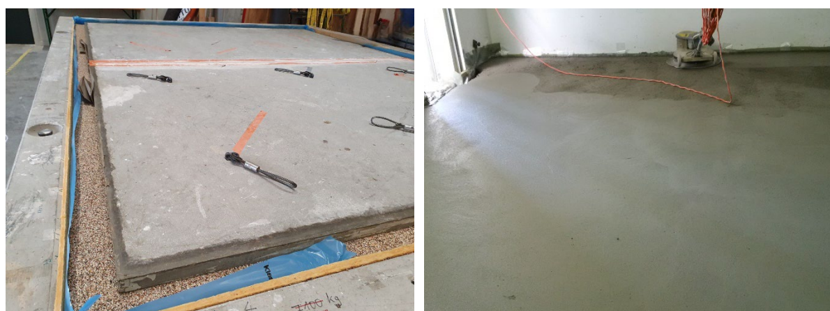
Abbildung 1: Links: Fertigteilplatte, rechts: Gelegter Estrich
